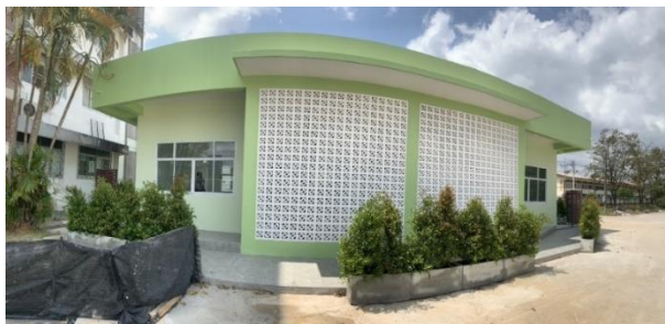
ภาพการดำเนินงานโครงการปรับปรุงอาคารละหมาด
